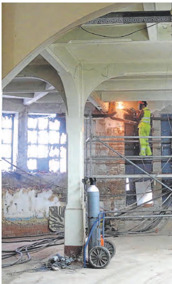
Trabajos de vaciado, ayer, en la aislada zona de obras. JUAN MARÍN
